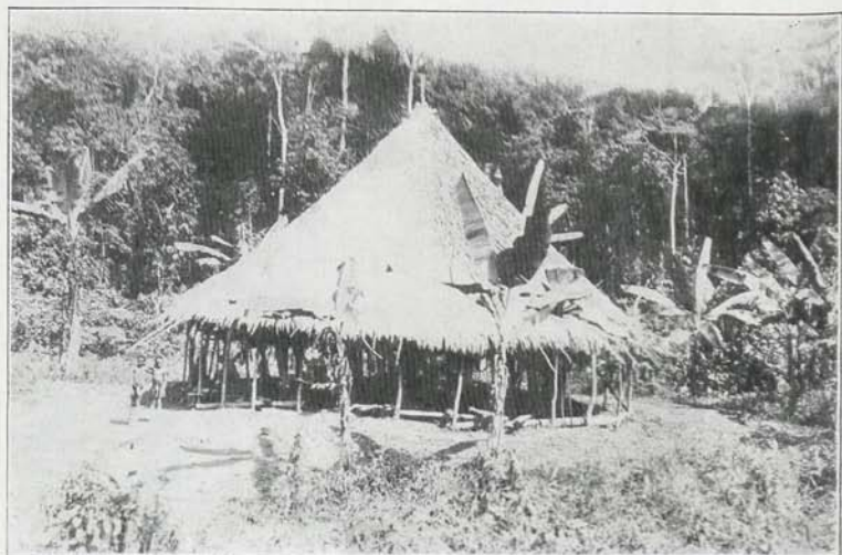
Mannenhuis, kampong Piesano.
