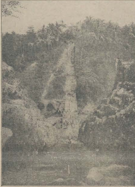
De voor de Siphon gemaakte ingraving.
